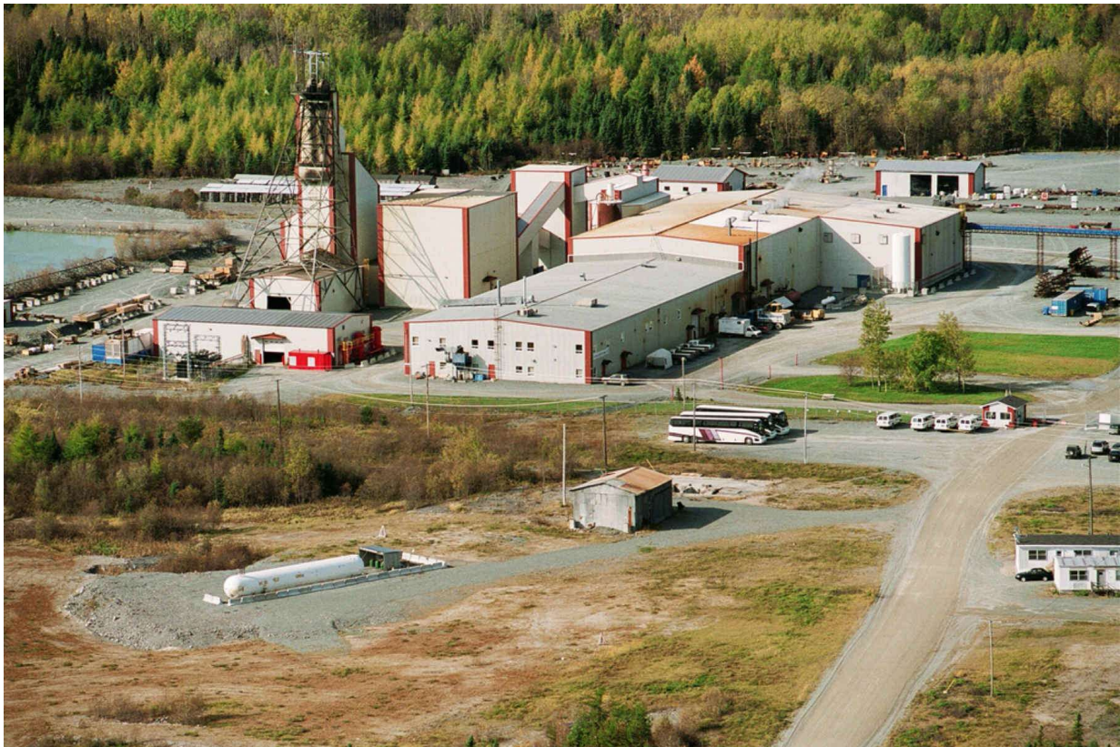
Installation de surface de la mine Géant Dormant
