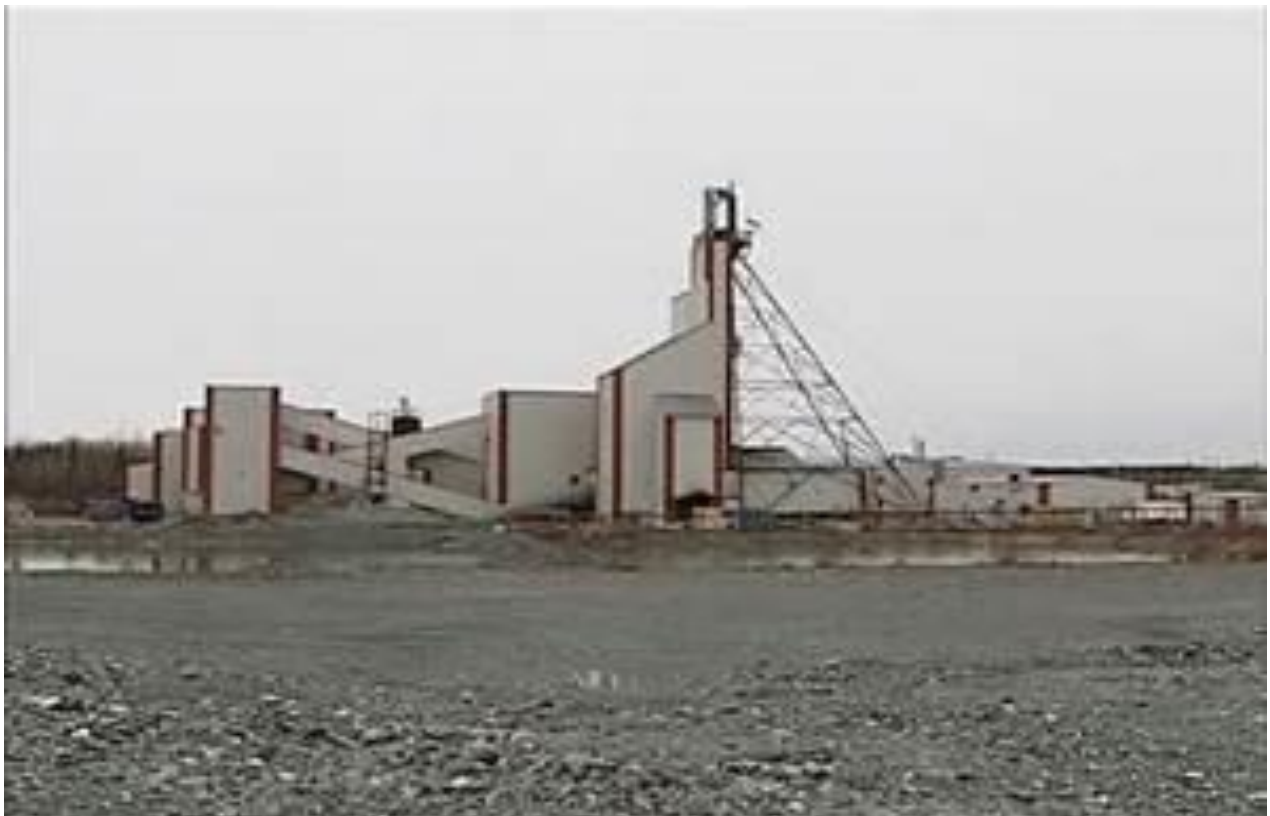
Installation de surface de la mine Géant Dormant
