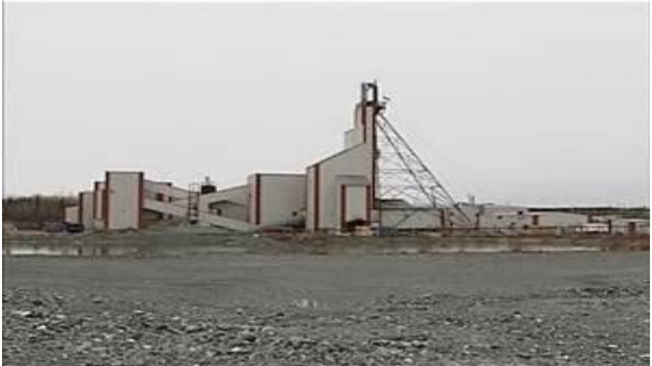
Installation de surface de la mine Géant Dormant
